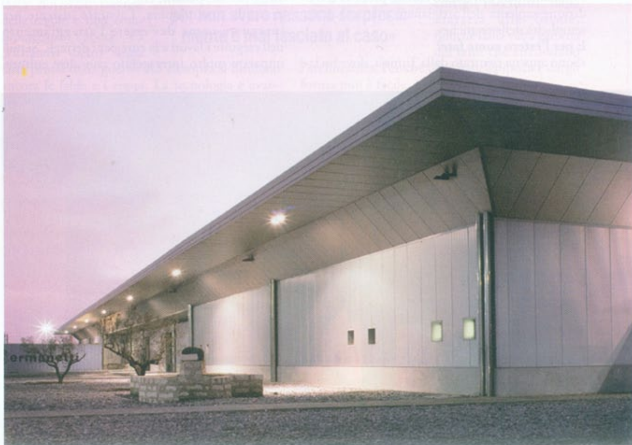
Il nuovo stabilimento della fabbrica Benetton Manufacturing sari, a Monastir, in Tunisia. Il progetto, realizzato nel 2003-2004, è di forma rettangolare, per un'area d'intervento di 9200 metri quadri
